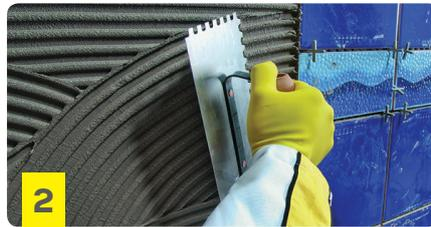
Extender sobre el soporte en paños pequeños de 1 m<sup>2</sup> aprox., peinando con una llana dentada para regularizar el espesor y proceder a la colocación.
