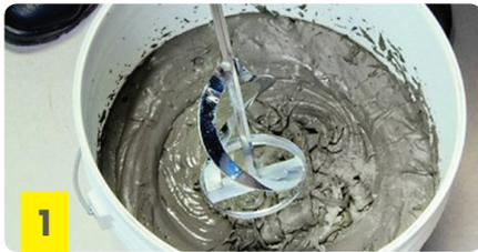
Colocar agua limpia en el balde. Luego, agregar **weber basic** paulatinamente (6 L por bolsa aprox.) y mezclar manualmente o con batidor eléctrico (500 rpm) hasta obtener una pasta homogénea. Dejar reposar 5 minutos.
