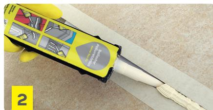
2 Cortar la punta del pico a bisel en la sección deseada. Introducir el conjunto en la pistola aplicadora. Rellenar la junta completamente, asegurándose de que el material quede en contacto con ambos lados de la misma.
