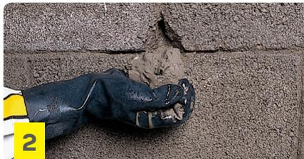
Aplicar realizando presión con los dedos, asegurándose que el producto vaya cubriendo desde el fondo hacia adelante. Realizar este procedimiento hasta completar el orificio. De ser necesario mantener la presión de manera sostenida entre 40 segundos y 1 min.
