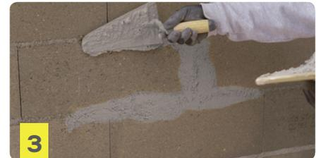
Se deberá repetir esta operación hasta asegurarse que no haya filtraciones de agua. Una vez terminado, alisar con ayuda de una cuchara.
