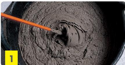
Amasar con aproximadamente 3,5 litros de agua limpia por bolsa de 25 kg, manual o mecánicamente (batidor eléctrico lento: 500 rpm) hasta obtener una mezcla homogénea.
