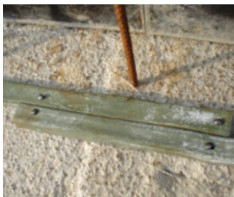
Solape de los extremos de Idrostop B25
