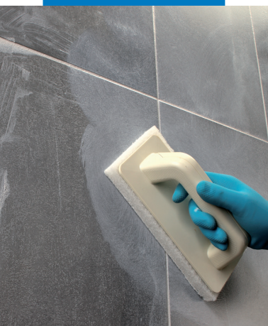
Limpieza de las baldosas con Scotch-Brite®
