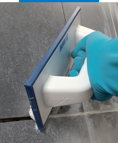
Aplicación de Flexcolor con lana de goma
