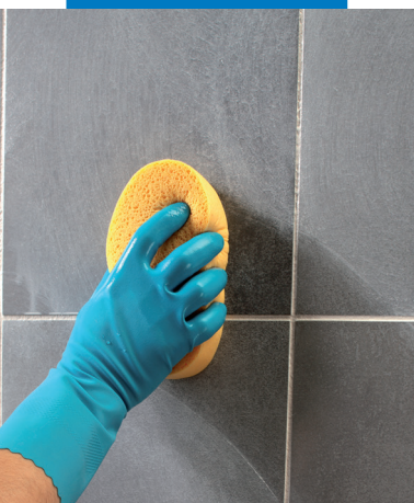
Acabado de la superficie con esponja de celulosa dura
