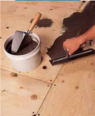
Rejuntado de soportes de madera contrachapada con Nivorapid + Latex Plus
