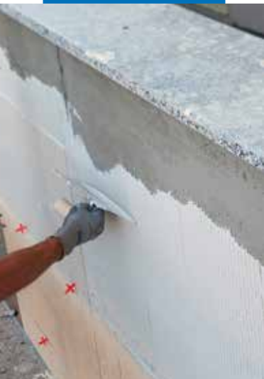
Colocación sobre fachada exterior, aplicación del adhesivo sobre el soporte
