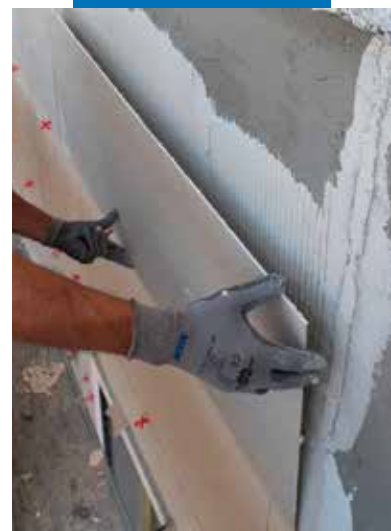
Aplicación de baldosa de gres porcelánico fino sobre fachada exterior
