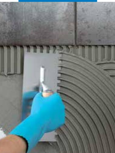
Extensión de Ultralite S1 con una llana dentada en pared
