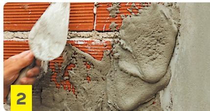
Aplicar con cuchara de albañil en capas sucesivas hasta obtener un espesor de aproximadamente 1,5 cm. Reglear y luego retirar las guías. Rellenar con el mismo material, presionando y asegurándose de no dejar huecos.
