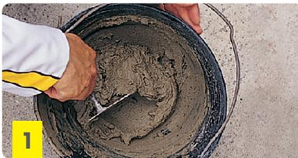
Amasar con aproximadamente 4,5/ 5,5 ltrs de agua limpia por bolsa de 30kg, manual o mecánicamente, hasta lograr una pasta homogénea. Dejar reposar entre 5 a 10 min aproximadamente.
