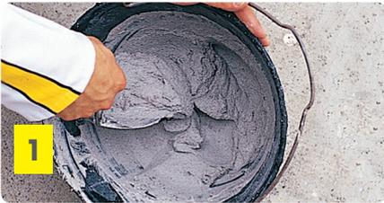
Colocar agua limpia en un balde y luego agregar weber.rev yeso GF paulatinamente. Utilizar un volumen de agua cada 2 volúmenes de weber.rev yeso GF. Mezclar manual o mecánicamente hasta obtener una pasta homogénea.
