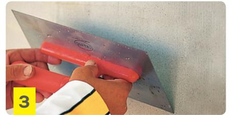
Terminar con llana plástica o metálica en un ángulo de 75° aproximadamente. Hacer sucesivas pasadas ascendentes para lograr un "planchado" de la superficie. De ser necesario, mojar la herramienta con agua limpia.
