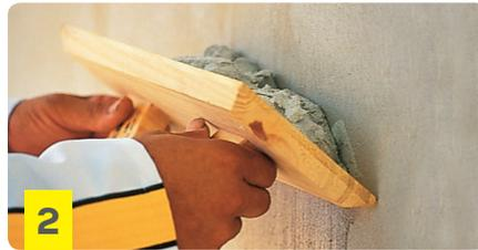
Extender con frataso en forma lineal hasta lograr el espesor deseado. Si es necesaria una segunda extensión, esperar a que la primera haya secado ligeramente.
