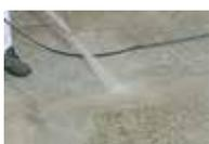
• El substrato deberá estar asentado, seco, libre de polvo, grasa y demás impurezas que pudieran dificultar la adhesión. Si es necesario, el substrato deberá ser tratado mecánicamente mediante abrasión mecánica tipo fresado, granallado o diamantado en función del soporte y posterior aspirado. • El soporte deberá tener una resistencia a la compresión mínima de 12 MPa y una resistencia a la tracción superior a 1,2 N/mm<sup>2</sup> (ensayo \*pull-off\*).
