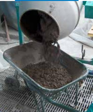
Mezcla de Mapegrout SV50 en hormigonera
