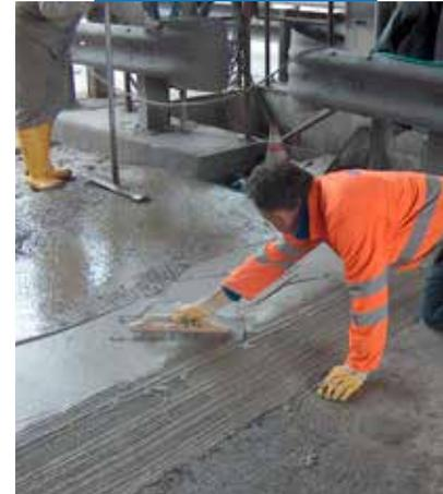
Aplicación de la mezcla confeccionada con **Mapegrout SV50**
