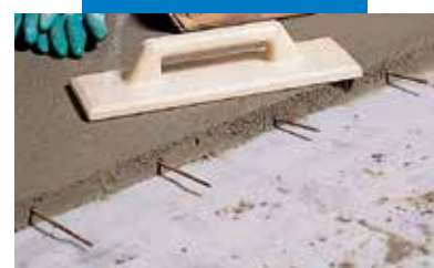
Detalle de la carpeta de Topcem con las llaves de la junta de trabajo
