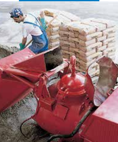
Mezcla de Topcem con sistema automático de bombeo
