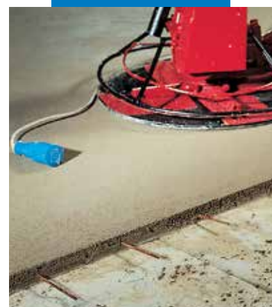
Acabado superficial con helicóptero
