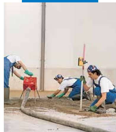
Aplicación de la mezcla de Topcem
