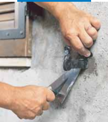
Colocación de grapas para ventanas con Lampocem
