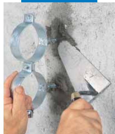
Fijación de abrazaderas para cañerías con Lampocem
