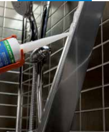
Adhesión de perfiles metálicos
