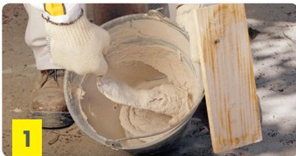
Amasar con aproximadamente 7 ltrs de agua limpia por bolsa de 25kg, manual o mecánicamente, hasta lograr una pasta homogénea. Dejar reposar aproximadamente 15 min.
