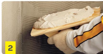
Extender de modo uniforme el producto con frataso de madera en dos manos hasta obtener un espesor de aproximadamente 3 mm.
