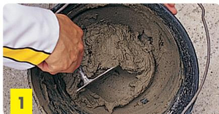
Colocar agua limpia en el balde, luego incorporar weber.tec refractorios y mezclar manual o mecánicamente hasta obtener una pasta homogénea (1 L de agua limpia cada 5 kg).
