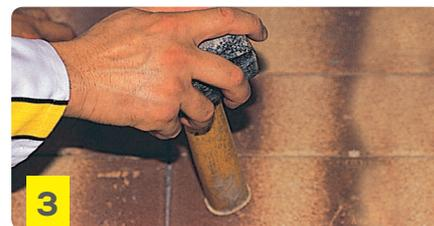
Colocar las piezas refractorias, presionar y nivelar la superficie. Empastinar con el mismo material 48 hs. posteriores a la colocación y 48 hs. después se sugiere dar fuego para mejorar el endurecimiento. Proteger de las lluvias hasta tanto no haya endurecido.
