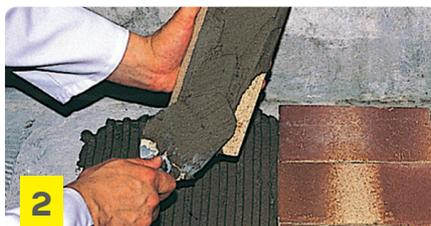
Dejar reposar 5 min., remezclar y extender sobre el soporte y sobre el revestimiento a colocar. Se debe regularizar el espesor con una llana de 12 mm.
