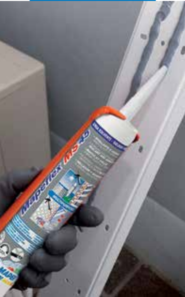
Adhiriendo perfiles de plástico en exteriores
