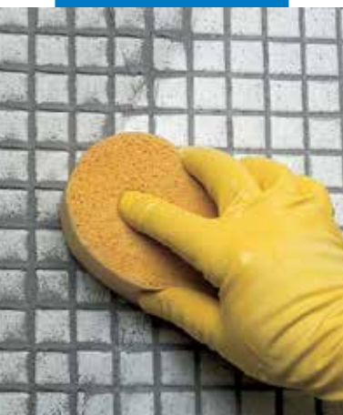
Terminación del relleno de juntas de mosaico vítreo con esponja
