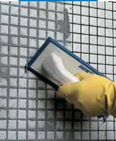
Relleno de junta de revestimientos de mosaico vítreo (en baño) con llana
