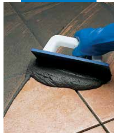
Relleno de juntas de monococción con llana
