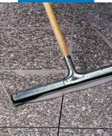
Relleno de juntas en pisos de granito preplido con rasqueta
