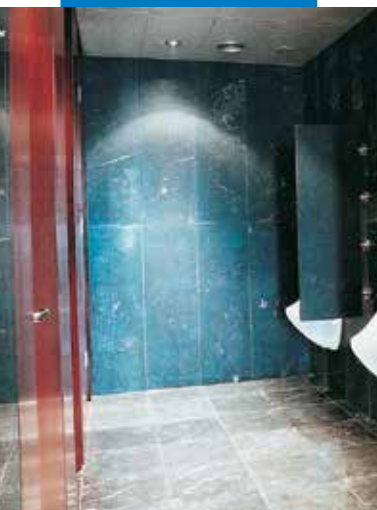
Ejemplo de colocación de mármol en paredes con Keraquick S1 - Baño del Casinò Feuchtwangen (Alemania)
