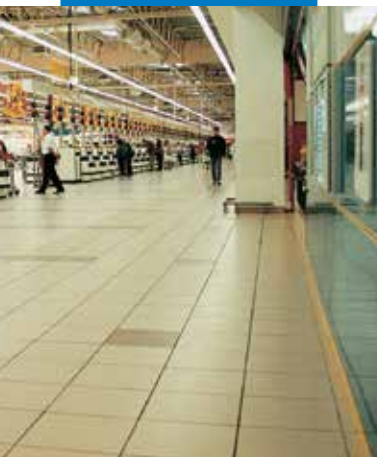
Ejemplo de colocación con Keraquick S1 en un supermercado Auchan - Sosnowiec (Polonia)
