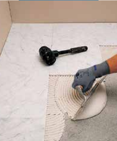
Colocación de mármol de Carrara blanco con Keraquick S1 blanco
