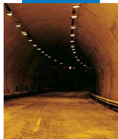
Aplicación por proyección de Planiseal 88 blanco en un túnel
