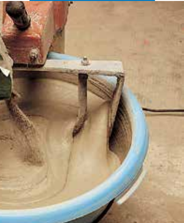
Mezclado de Planiseal 88 gris con agua
