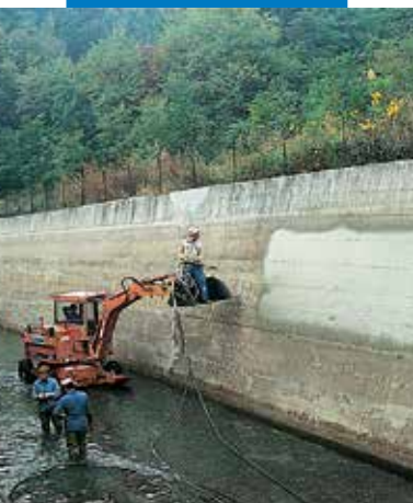
Aplicación por proyección de Planiseal 88 en un canal hidroeléctrico
