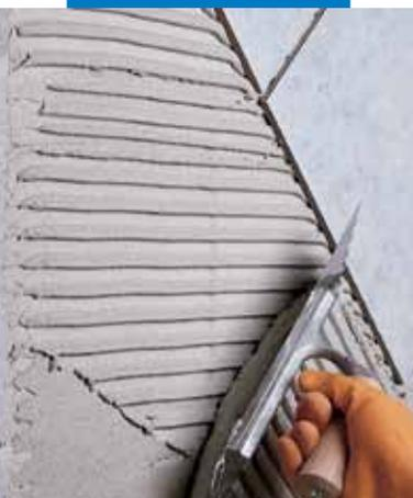
Colocación de revestimientos sobre paredes de bloques de hormigón celular
