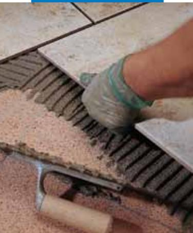
Sobreposición de un revestimiento de monococión sobre baldosas ya existentes
