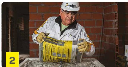
Mezclar el producto a razón de 550 ml a 6 litros de agua por bolsa (aplicación manual o maquinada) o 650 l/h. en máquina revocadora **M-tec duo mix**. Una vez mezclado, comprobar si la fluidez es la indicada, con el **weber medidor de fluidez**.
