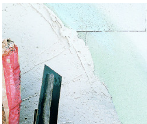
Uso como imprimación para revoques de yeso
