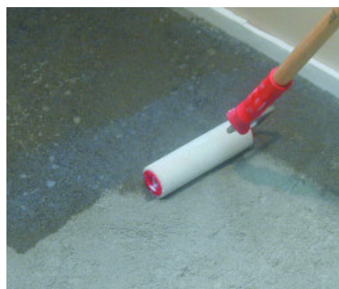
Aplicación de Primer G con rodillo
