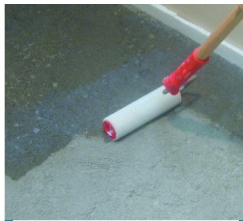
Aplicación de Primer G con rodillo
