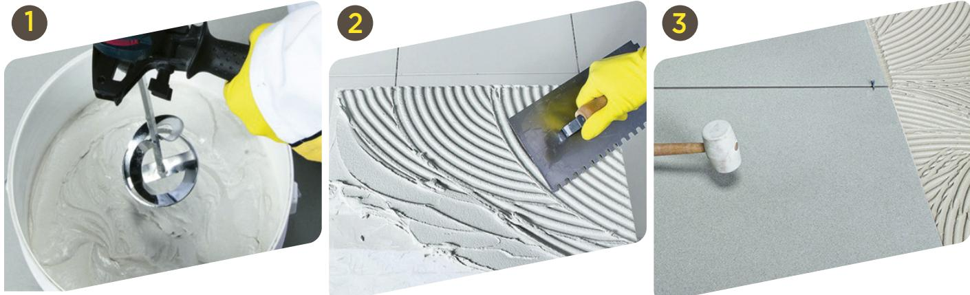
Colocar agua limpia en el balde (8,25 A 8,75 lts aprox. por bolsa), luego agregar **weber superformatos** paulatinamente. Mezclar hasta obtener una pasta homogénea.
