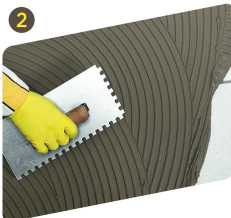
2 Extender sobre el soporte en paños pequeños de 1 m2 aprox., peinando con una llana dentada para regularizar el espesor y proceder a la colocación.
