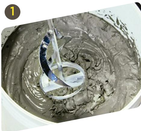
1 Colocar agua limpia en el balde (5 lts por bolsa aprox.) luego agregar **weber piso sobre piso 12 hs** paulatinamente y mezclar manualmente o con batidor eléctrico (500 rpm) hasta obtener una pasta homogénea. Dejar reposar 5 minutos.
