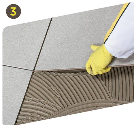
3 Colocar las piezas, presionarlas hasta conseguir el aplastamiento de los surcos, dejando la junta recomendada por el fabricante de las piezas (mínimo 3 mm). Tomar la junta a partir de las 6 h de la colocación con productos de la gama **weber pastina prestige**.
