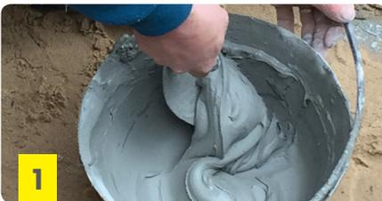
1 Amasar con aproximadamente 2,8 a 3 litros de agua limpia por bolsa de 8 kg (cada 1 kg de material agregar entre 0,35 y 0,37 litros de agua).
