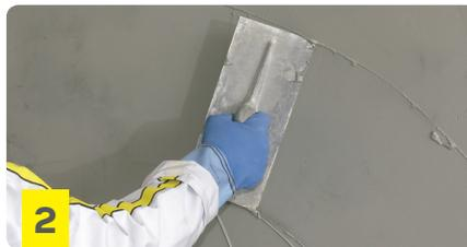
2 Extender el material de modo uniforme con llana metálica hasta conseguir el espesor deseado. Apretar fuertemente sobre el sustrato para lograr tapar todas las imperfecciones de la superficie.
