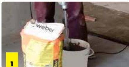
1 Amasar **weber top** con 4,5 litros de agua limpia por bolsa de 25 kg, con un batidor eléctrico lento (500 rpm), hasta obtener una pasta fluida y homogénea. Dejar reposar la mezcla 2 minutos.
