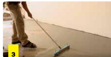
3 Extender y alisar con una llana niveladora. Utilizar un rodillo con púas para eliminar el aire del producto.
