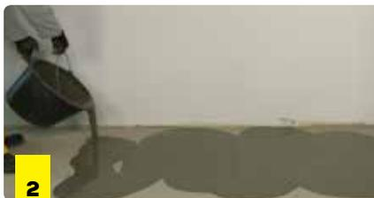
2 Verter la mezcla sobre el suelo y reglear en espesor.
