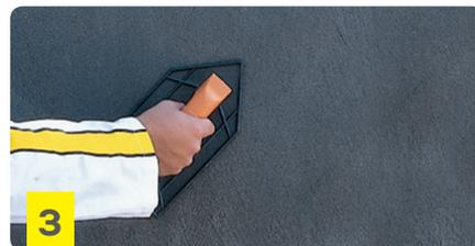
El acabado se puede realizar con frataso o fieltro según la textura deseada. Puede revestirse con pinturas, revoques y/o cerámicos.
