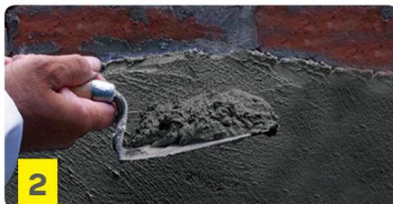
Proyectar con cuchara y reglear. Las fajas de nivel pueden hacerse con el mismo producto hasta lograr un espesor mínimo de 10 mm. Para aplicaciones superiores, realizarlo en sucesivas pasadas. La base a colocar, debe estar firme, absorbente y húmeda.
