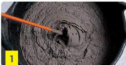
Colocar agua limpia en el balde u hormigonera, luego agregar **weber imper G** paulatinamente 4L por bolsa, mezclar manual o mecánicamente, hasta conseguir una masa homogénea.
