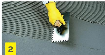
2 Extender sobre el soporte en paños pequeños de 1 m<sup>2</sup> aprox., peinando con una llana dentada para regularizar el espesor y proceder a la colocación.
