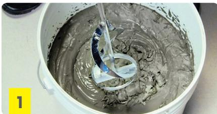
1 Colocar agua limpia en el balde. Luego, agregar **weber pro** paulatinamente (6 L por bolsa aprox.) y mezclar manualmente o con batidor eléctrico (500 rpm) hasta obtener una pasta homogénea. Dejar reposar 5 minutos.
