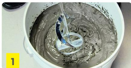
1 Colocar agua limpia en el balde, luego agregar **weber piso sobre piso 12hs** paulatinamente (6 L por bolsa aprox.) y mezclar manualmente o con batidor eléctrico (500 rpm) hasta obtener una pasta homogénea. Dejar reposar 5 minutos.
