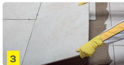
3 Colocar las piezas, presionarlas hasta conseguir el aplastamiento de los surcos, dejando la junta recomendada por el fabricante de las piezas (mínimo 3 mm). Tomar la junta a partir de las 6 hs. de la colocación con productos de la gama weber.color prestige o epoxi
