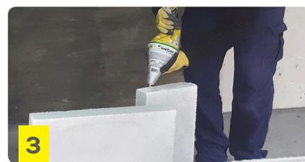
3 En ladrillos de hormigón celular colocar además dos cordones de manera vertical, en los laterales
