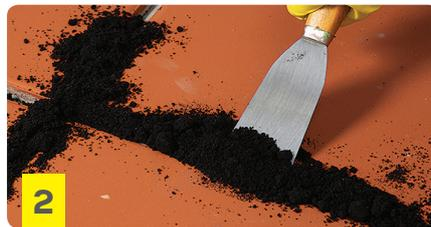
Rellenar las juntas con una espátula, cuidando de no manchar la superficie. Compactar la masa con un toma juntas, retirar el excedente y humedecer con agua en forma de rocío, hasta que aparezca el brillo superficial. Volver a humedecer a las 6 horas.
