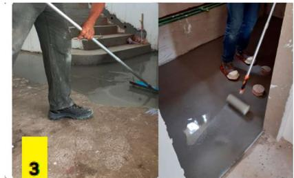
3 . Volcar el producto sobre la superficie a nivelar, extender con ayuda del rastrillo y utilizar el rodillo de púas para eliminar la mayor parte de las burbujas de aire que se le pueden haber incorporado a la pasta consecuencia del mezclado con batidor.
