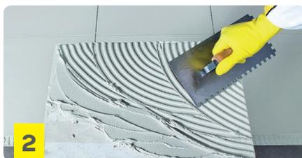
Extender con llana N°6 sobre el soporte en paños pequeños (1 m<sup>2</sup> aprox.). Realizar un doble encolado de 1 o 2 mm de espesor con la parte lisa de la llana sobre la pieza. Si la superficie no está suficientemente regular, utilizar llana dentada sobre la pieza o llana mayor sobre el soporte.
