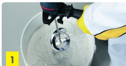
Colocar agua limpia en el balde, luego agregar **weber slim** paulatinamente (5,5 L por bolsa). Mezclar hasta obtener una pasta homogénea. Dejar reposar 5 minutos.
