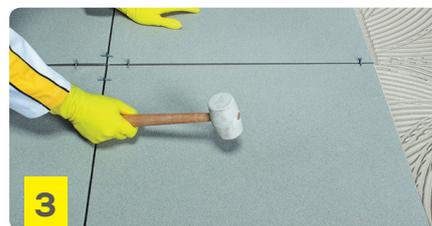
Colocar la pieza y presionar hasta conseguir el aplastamiento de los surcos. Respetar la junta entre piezas indicada por el fabricante de las piezas (mínimo 3 mm). Transcurridas 24 hs. tomar la junta con **weber prestige** o con **weber epoxi plus**.
